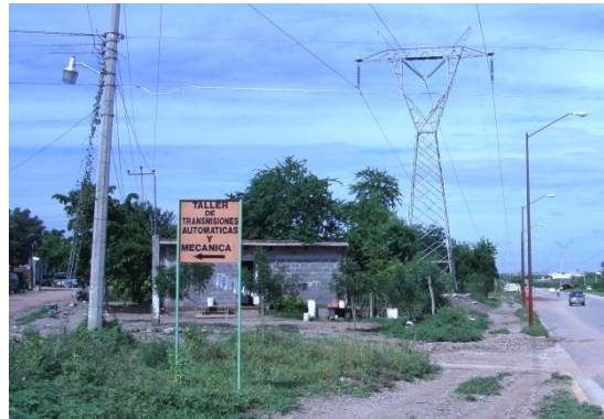
Imagen 51. Líneas de alto voltaje de la C.F.E.
